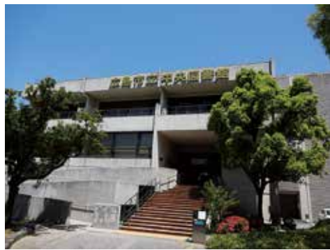
現在の外観 南側
